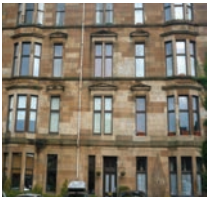
Tenement Flats (exc main door flats) 675, 43.7%
